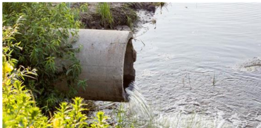
Slika 1.2 Nekontrolirani ispušt nepročišćene otpadne vode u prirodne vodotoke. 9
