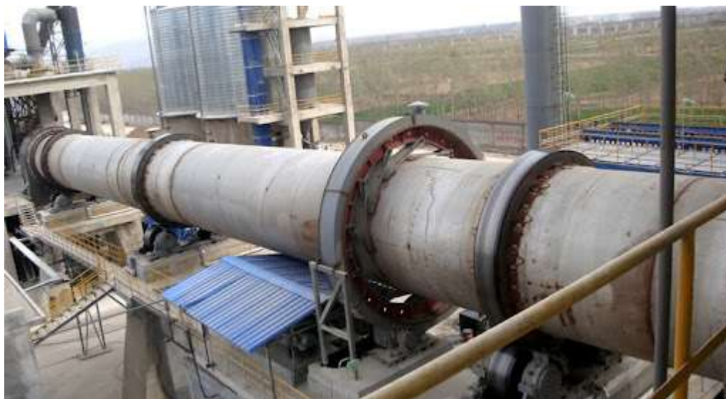
Slika 1. Prikaz rotacijske peći 1 za proizvodnju portland cementa
