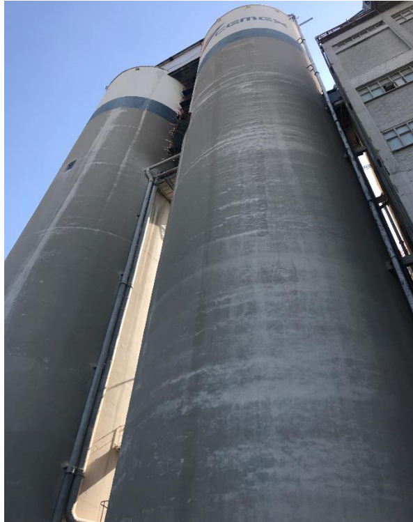
Slika 3. Silosi za homogenizaciju u tvornici Sv. Kajo
