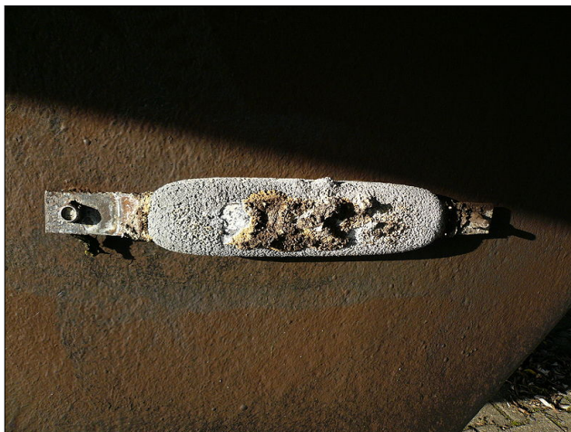
Slika 10.) Korodirana žrtvovna anoda od cinka postavljena na trup broda
