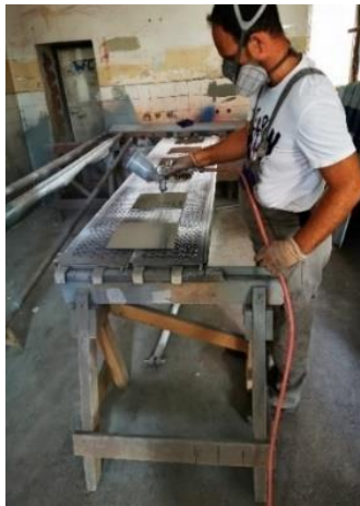
Slika 9. Postupak nanošenja prvog premaza Hempadur 155707/12340.
