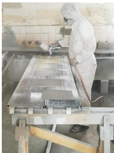
Slika 10. Postupak nanošenja drugog premaza Hempadur quattro 17634/22090.
