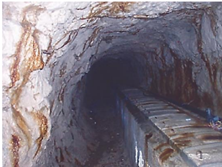
Slika 24. Hidrotehnički tunel kroz Srđ. 30
