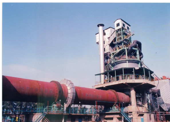
Slika 2. Rotacijska peć za proizvodnju klinkera 3
