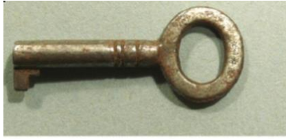
Slika 4. Korozija ključa izazvana električnom mikrobiološkom korozijom. 9
