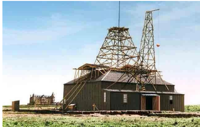
Slika 1.4. Vanjski izgled Teslinog Wardenclyffe laboratorija, Shoreham, 1899. [11]
