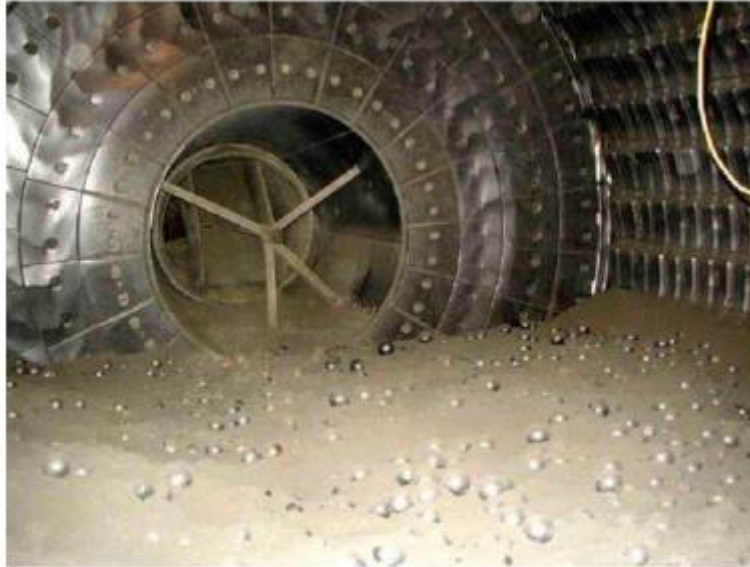
Slika 18. Unutrašnjost mlina s kuglama za mljevenje klinkera [5]
