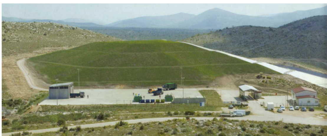
Slika 1.5. Lokacija odlagališta otpada Bikarac u Šibeniku (izvor: Google Earth). 10
