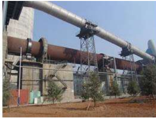
Slika 2. Rotacijska peć u postrojenju za dobivanje cementa 3
