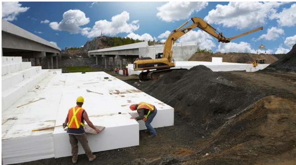
Slika 16. Upotreba pjenastog polistirena u građevinarstvu 17
