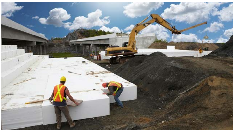
Slika 16. Upotreba pjenastog polistirena u građevinarstvu 17
