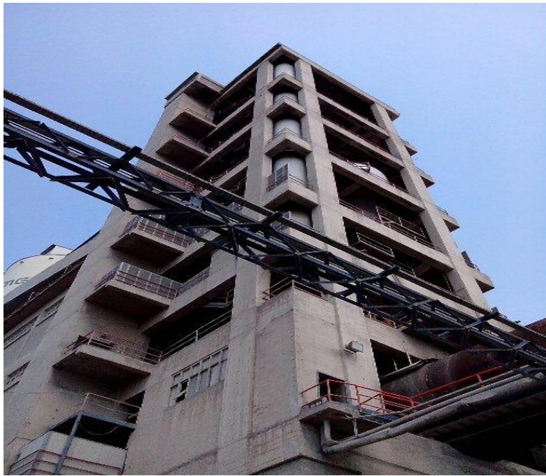
Slika 4. Toranj sa ciklonima za pregrijavanje u tvornici sv. Kajo
