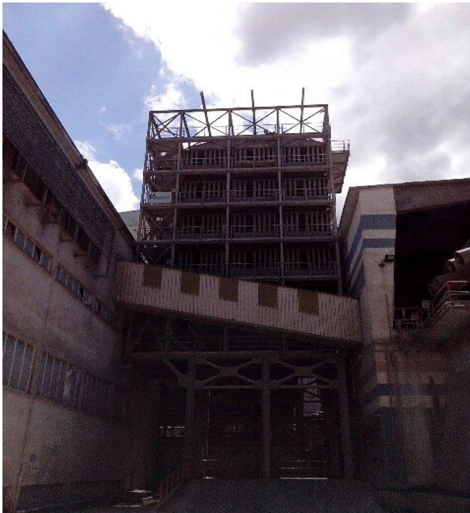
Slika 10. Prikaz hladnjaka klinkera u tvornici sv. Kajo
