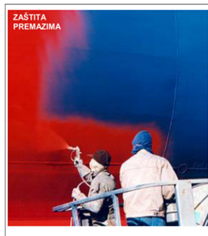
Slika 23. Zaštita od korozije primjenom premaza 49
