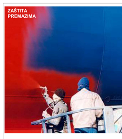
Slika 23. Zaštita od korozije primjenom premaza 49
