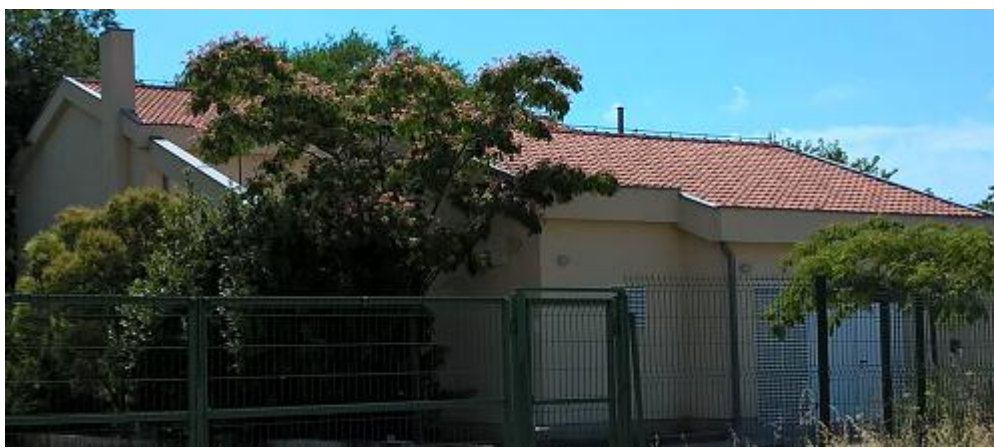
Slika 1.6. Crpna stanica Mandalina.
