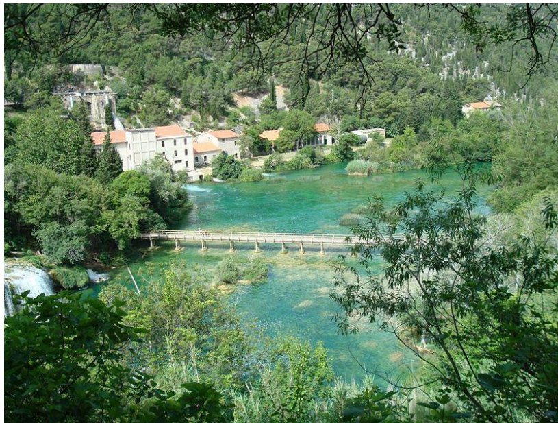
Slika 1.3. Crpilište i hidroelektrana Jaruga 11 .
