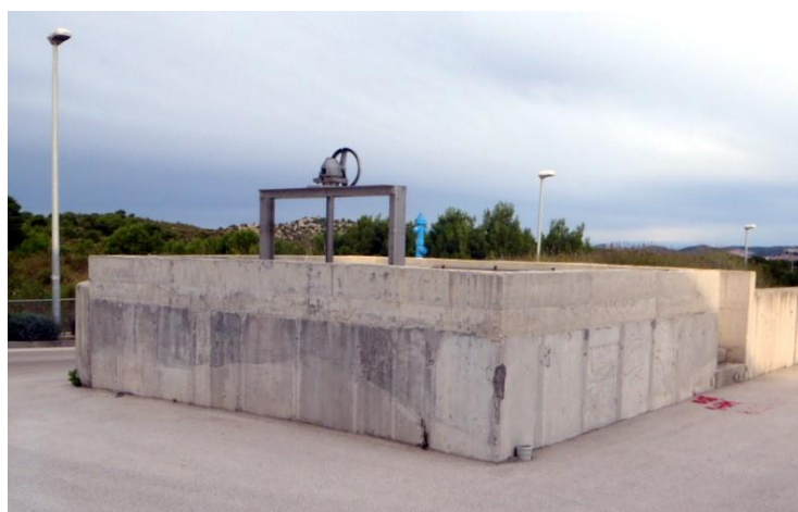
Slika 1.12. Ulazno okno.
