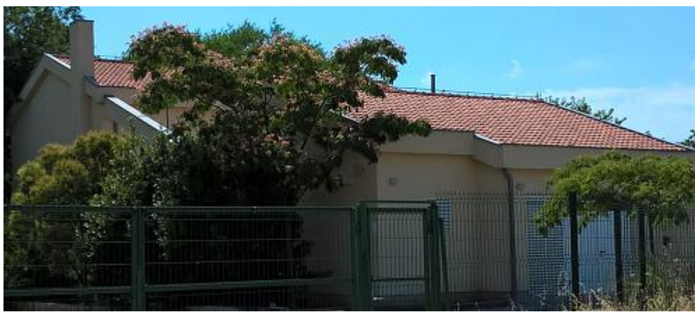
Slika 1.6. Crpna stanica Mandalina.
