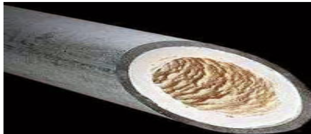
Slika 2.15. Naslage kamenca unutar vodovodne cijevi 45 .
