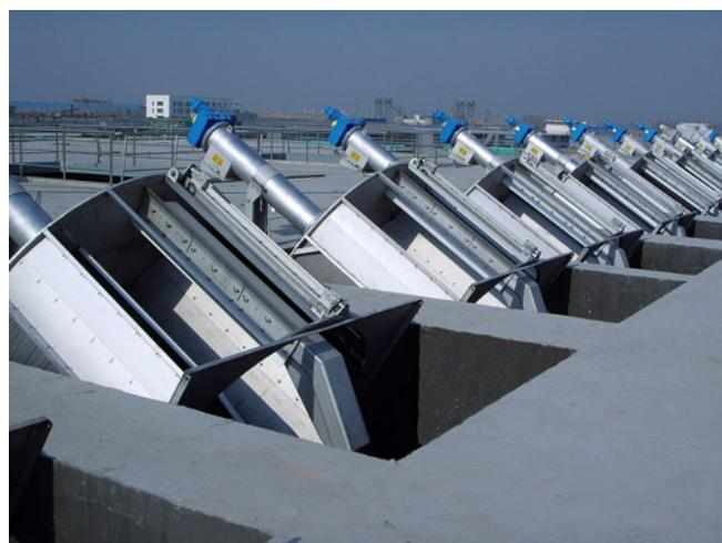
**Slika 6.** Prikaz fine rešetke HUBER ROTAMAT® Fine Screen Ro1 kao polifunkcionalne zasebne jedinice u procesu obrade otpadne vode – izdvajanje, pranje, sabijanje i transport materijala
