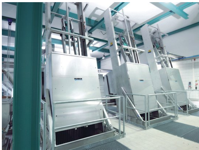
Slika 5. Prikaz grube rešetke HUBER CLIMBMAX® koja se postavlja u kanale ispred uređaja za obradu otpadnih voda u svrhu zaštite finih rešetki i drugih pogonskih elemenata od krupnijih onečišćenja
