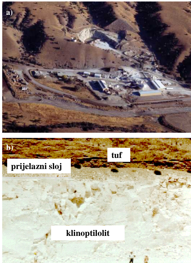
Slika 2.2. a) St. Cloud rudnik klinoptilolita, New Mexico i b) površinski kop klinoptilolita 22 .
