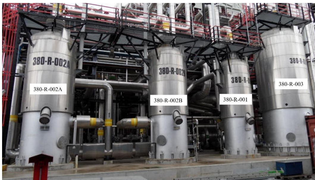
Slika 10. Reaktori za katalitičku hidrogenaciju i desulfurizaciju 380-R-001, 380-R-002A/B i Shift reaktor 380-R-003 17
