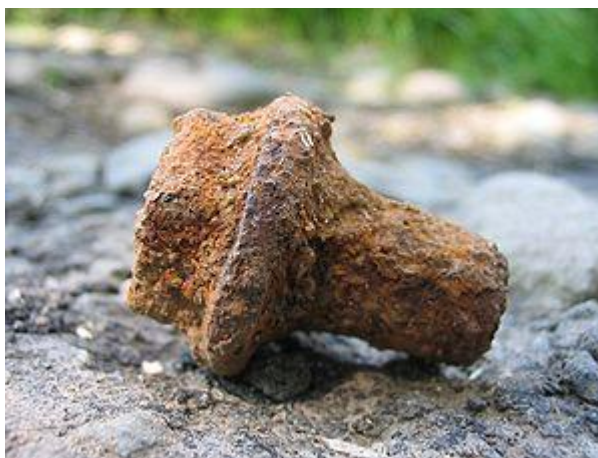
Slika 6. Dugotrajno izlaganje atmosferskim uvjetima poput vlage, kiše i snijega dovodi do korozije metala. 13
