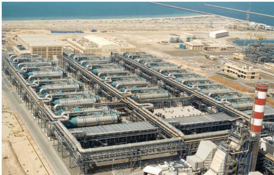
Slika 11. MSF postrojenje u Ras Al-Khairu 15
