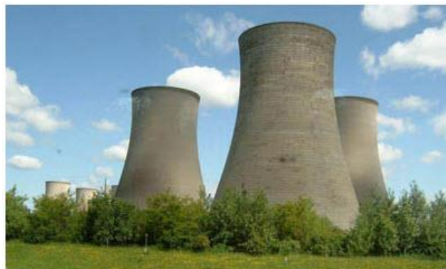
Slika 5. Rashladni tornjevi termoelektrana 11
