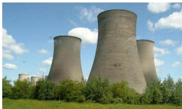
Slika 5. Rashladni tornjevi termoelektrana 11
