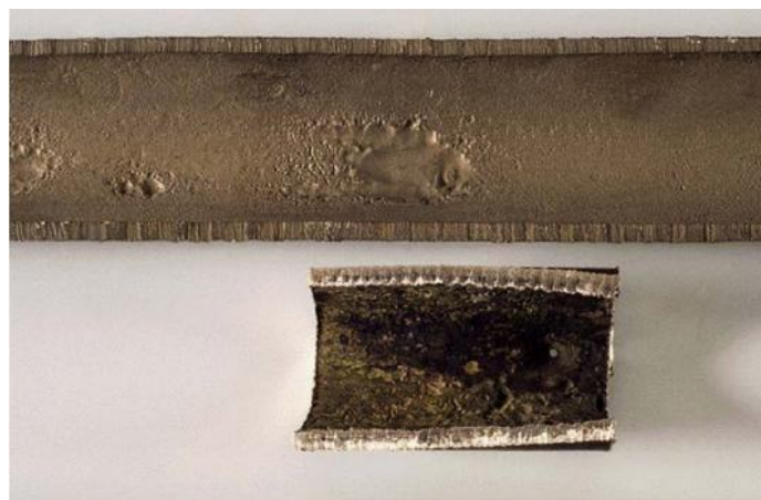
Slika 4. Erozijska korozija CuNi legure 25
