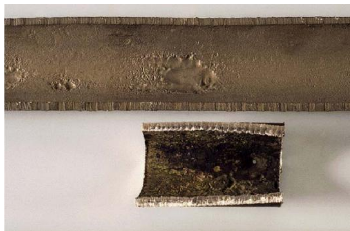
Slika 4. Erozijska korozija CuNi legure 25
