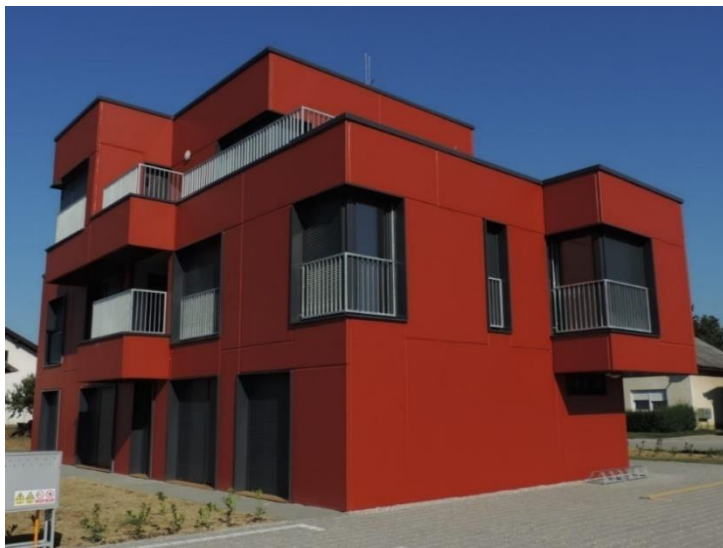
Slika 19. Prva ECO-SANDWICH kuća 33
