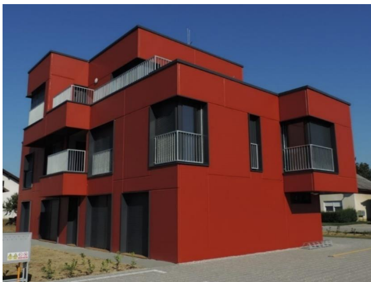
Slika 19. Prva ECO-SANDWICH kuća 33
