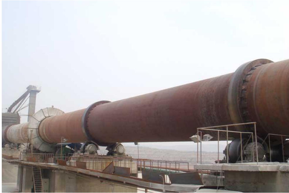
Slika 1.2. Rotacijska peć za proizvodnju cementa 2
