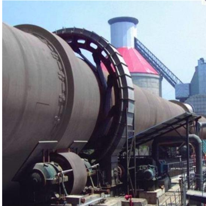
Slika 1.3. Klizni ležajevi rotacijske peći 5
