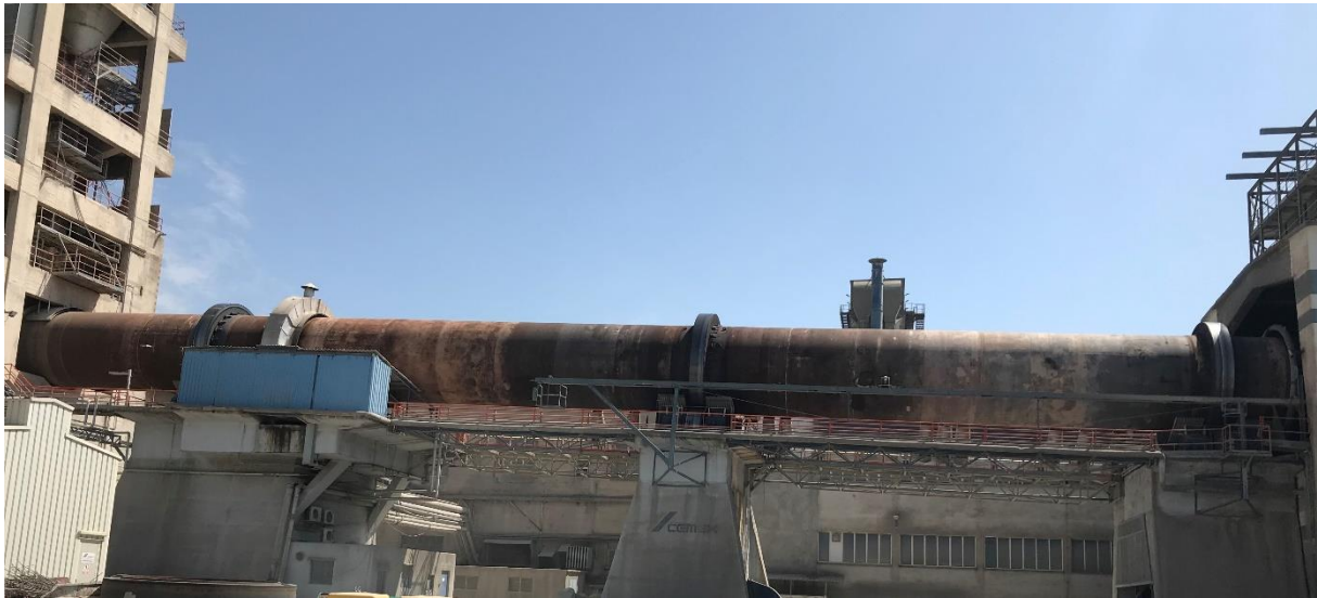
Slika 6. Rotacijska peć za pečenje klinkera u tvornici Sv. Kajo
