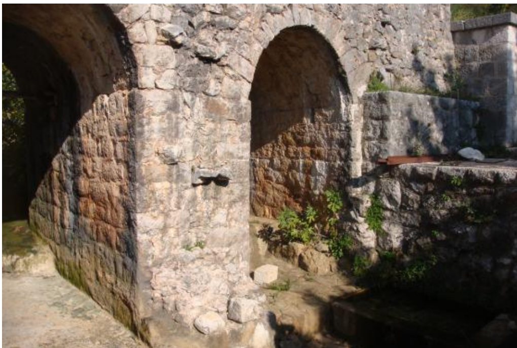
Slika 8. Ostaci starog dubrovačkog vodovoda. 16
