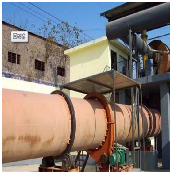
Slika 3. Klizni ležajevi rotacijske peći 3
