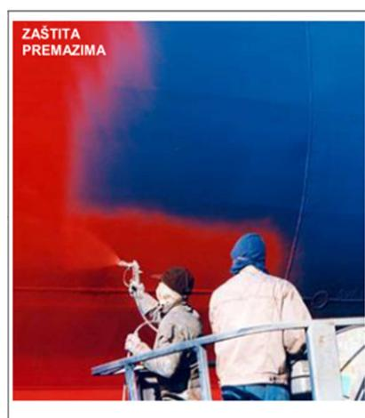
Slika 23. Zaštita od korozije primjenom premaza<sup>49</sup>
