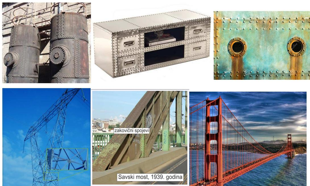
Slika 27. Spajanje metalnih konstrukcija zakovicama<sup>65,66</sup>
