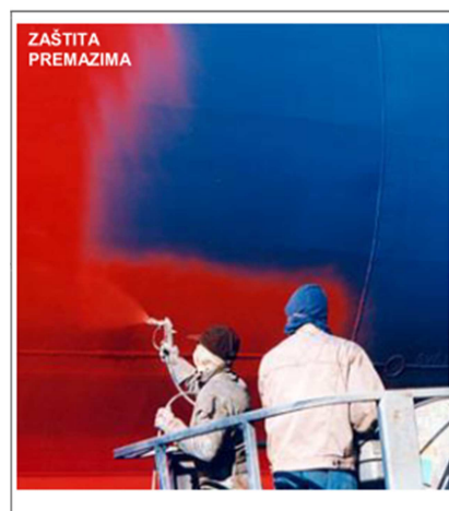
Slika 23. Zaštita od korozije primjenom premaza 49
