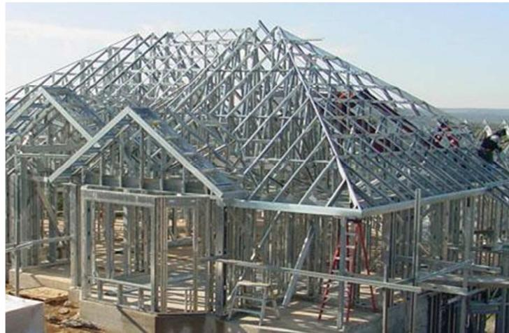
Slika 9. Konstrukcija od građevinskog čelika<sup>20</sup>
