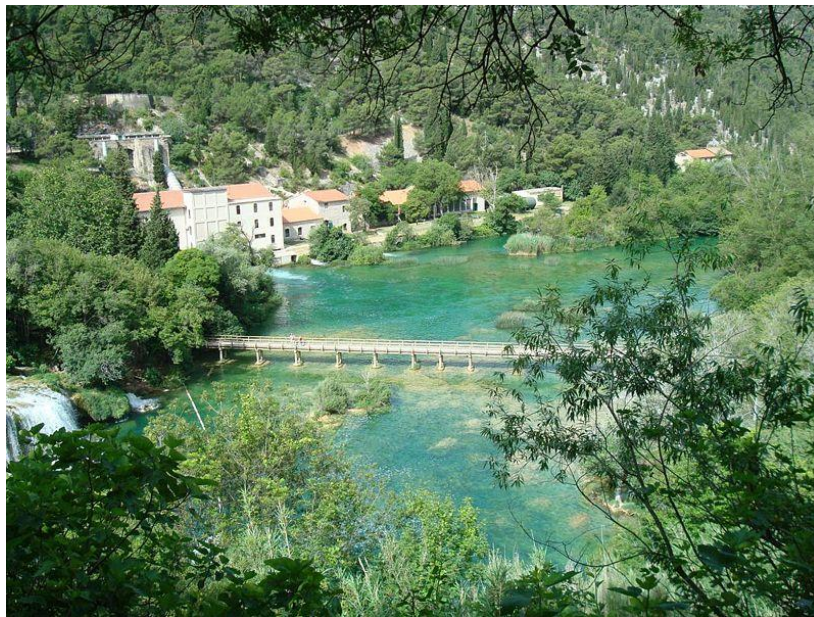
Slika 1.3. Crpilište i hidroelektrana Jaruga 11 .
