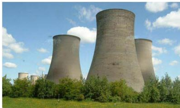
Slika 5. Rashladni tornjevi termoelektrana 11
