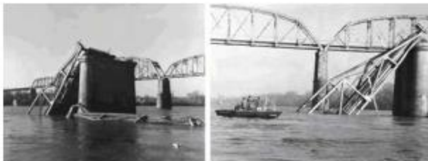
Slika 21. Posljedica napetosne korozije. 18
