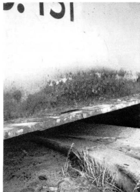
*Slika 6. Opća korozija (hrđanje) čeličnog nosača mosta autoseste koji je izložen vremenskim utjecajima.<sup>1</sup>*
