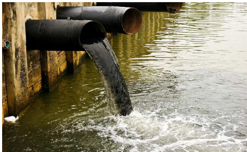
Slika 1.3. Primjer ispuštanja otpadne vode u okoliš 8
