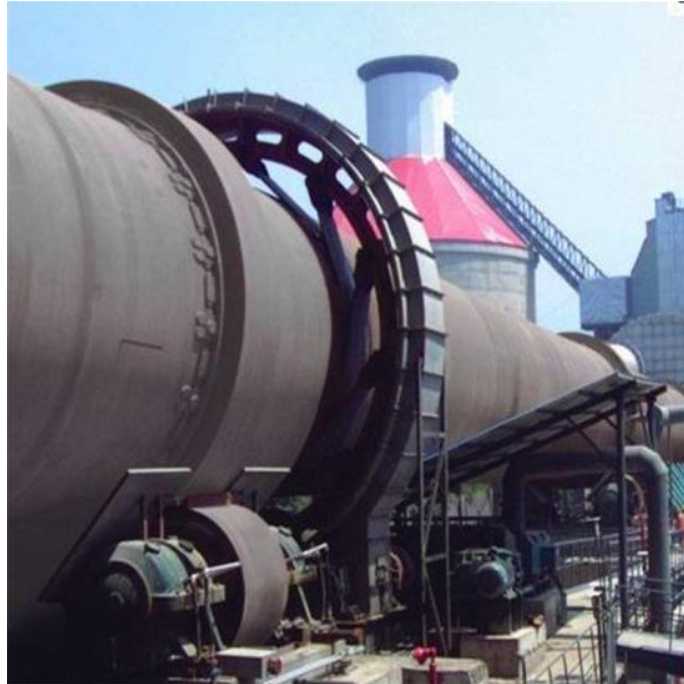
Slika 1.3. Klizni ležajevi rotacijske peći 5
