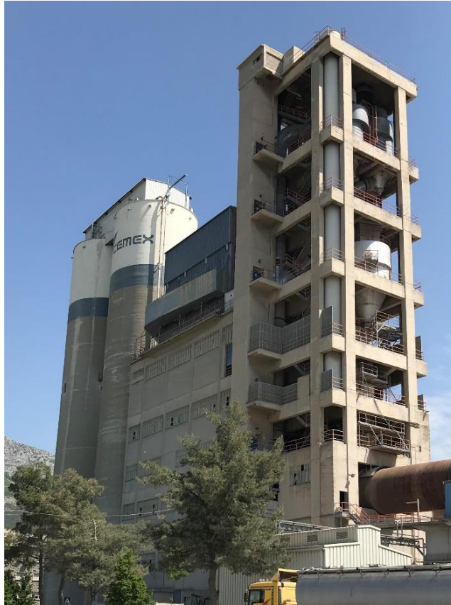
Slika 4. Toranj sa ciklonima za predgrijavanje u tvornici Sv. Kajo
