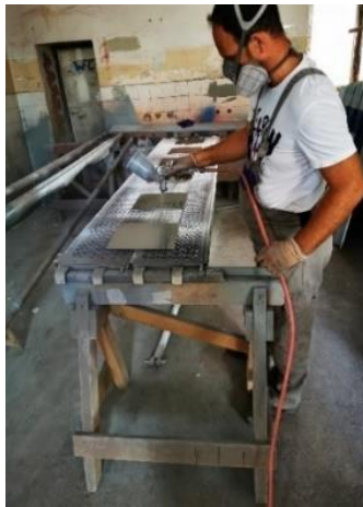
Slika 9. Postupak nanošenja prvog premaza Hempadur 155707/12340.
