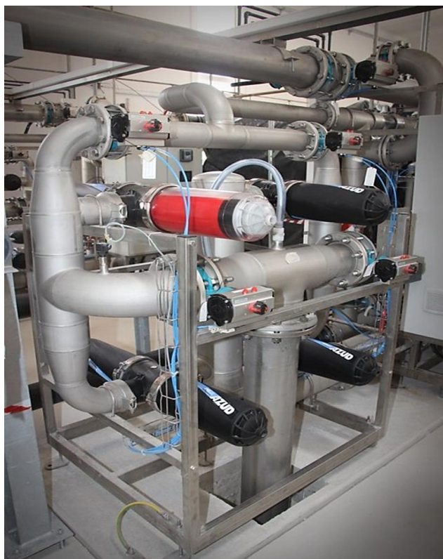
Slika 29. Sustav mehaničkih filtara tipa AZUD-Spin Klin .
