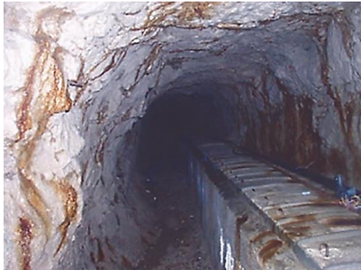
Slika 24. Hidrotehnički tunel kroz Srđ. 30
