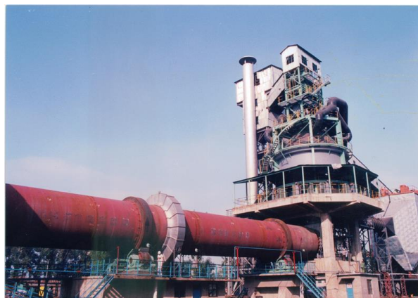
Slika 2. Rotacijska peć za proizvodnju klinkera 3
