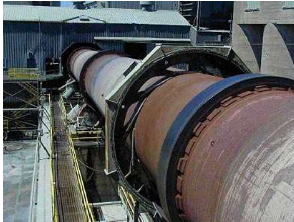
Slika 4. Klizni ležajevi rotacijske peći 5
