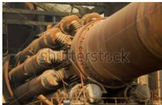
Slika 3. Rotacijska peć – procesna jedinica za proizvodnju klinkera 3
