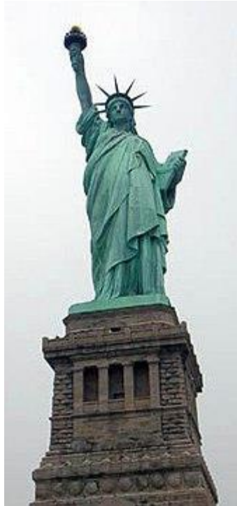
Slika 3. Kip slobode, New York, SAD - primjer prirodno formirane patine na bakru 6
