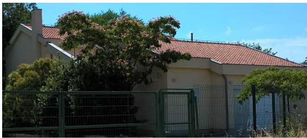
Slika 1.6. Crpna stanica Mandalina.
