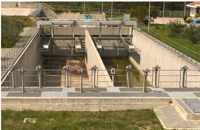
Slika 1.21. Primarni taložnik.
