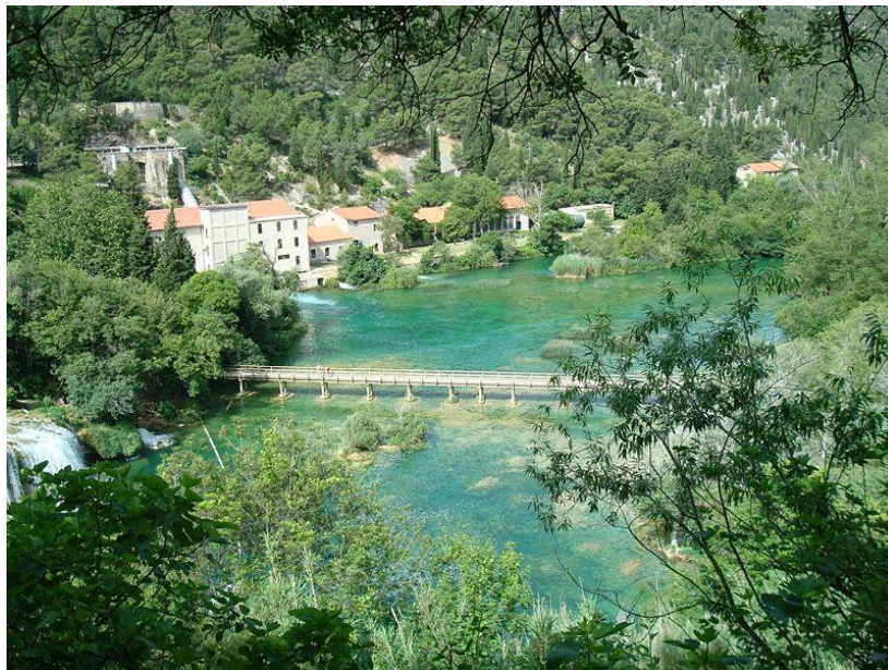
Slika 1.3. Crpilište i hidroelektrana Jaruga 11 .
