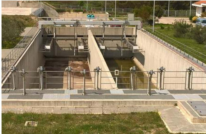
Slika 1.21. Primarni taložnik.
