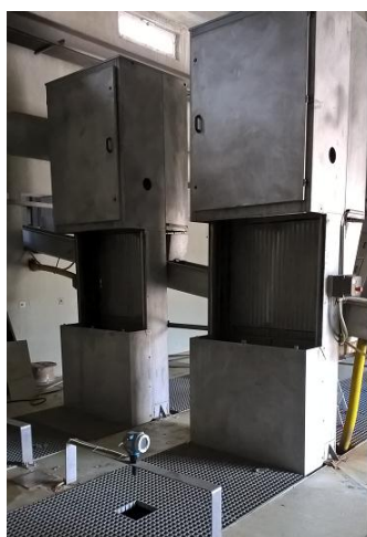
Slika 1.14. Grube rešetke.
