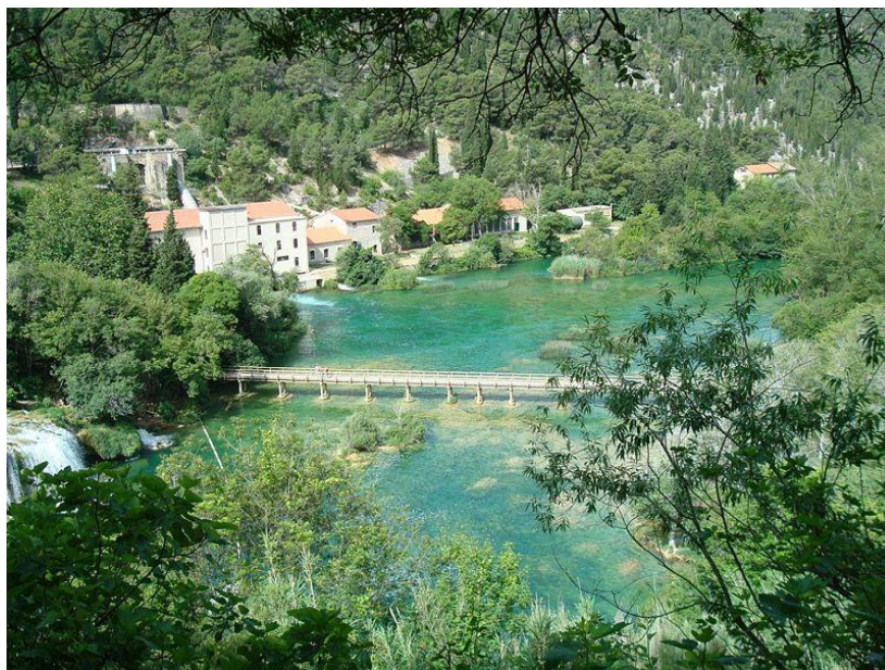
Slika 1.3. Crpilište i hidroelektrana Jaruga 11 .
