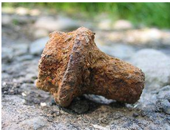
Slika 6. Dugotrajno izlaganje atmosferskim uvjetima poput vlage, kiše i snijega dovodi do korozije metala. 13
